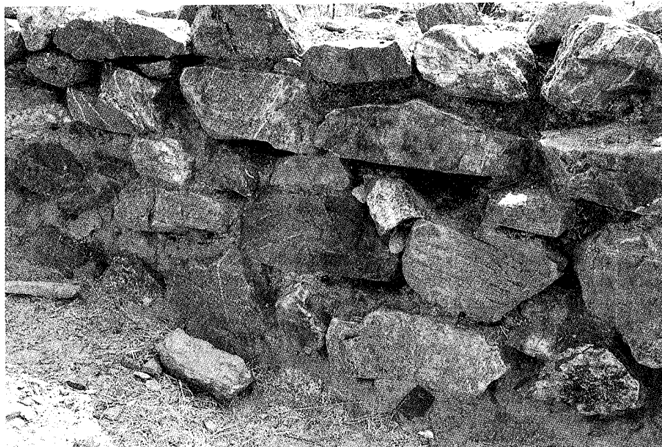
Fig. 14 - Piura la Vieja, muros.
