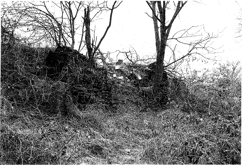
Fig. 16 - Ala, muros de contención.
